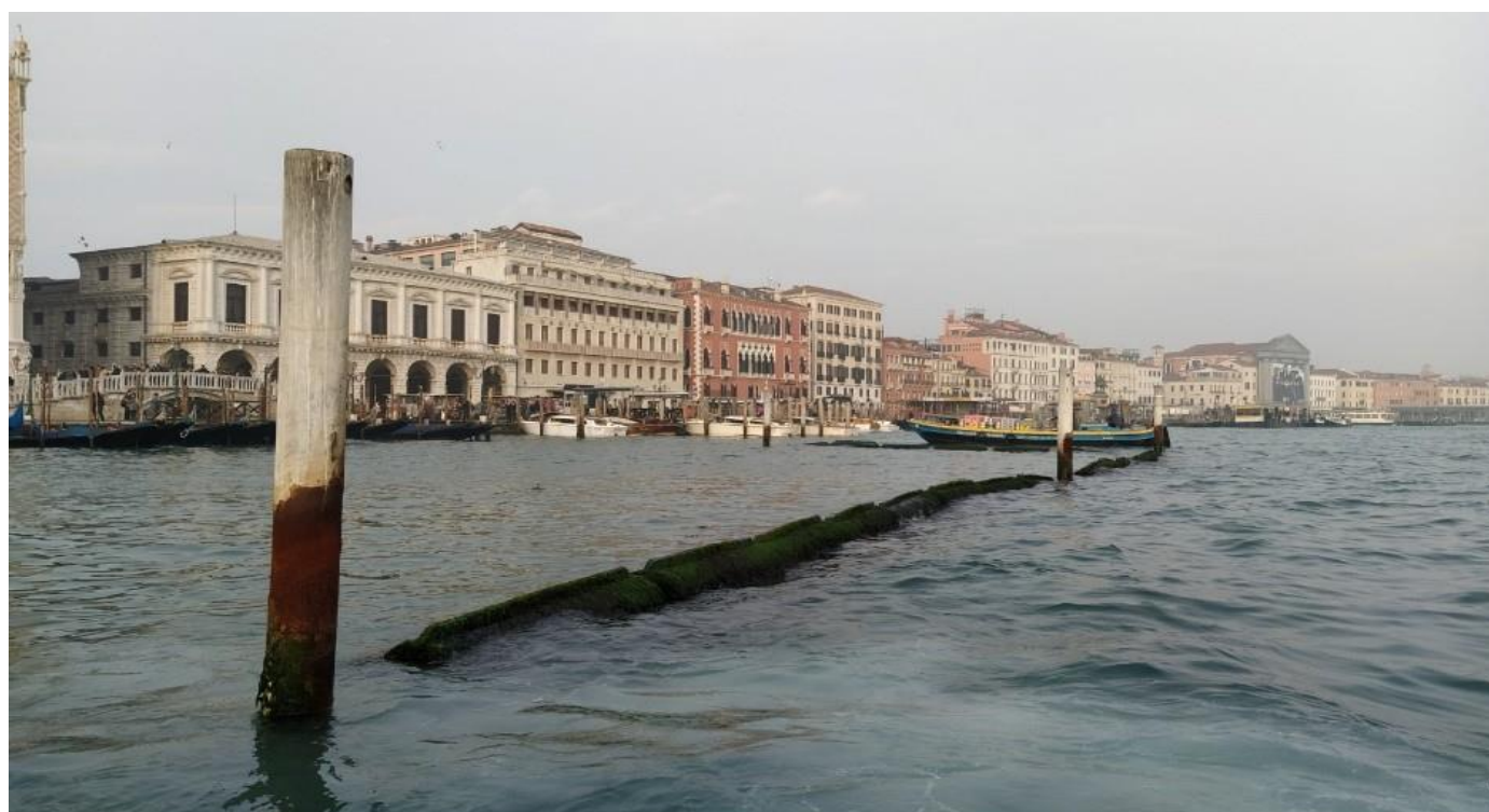
Figura 2. Foto dei pali di ancoraggio del frangiflutti Ondarail, posizionati in bacino San Marco, davanti a Palazzo Ducale
